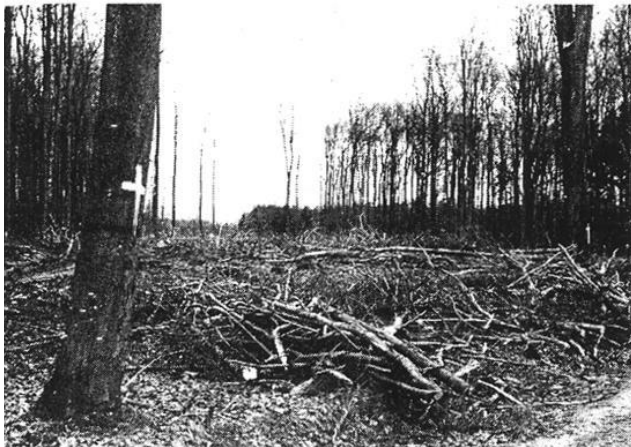
Trauriges Panorama in der Nähe des Franzosenecks - in einer "Nacht- und Nebelaktion" (Himmelhuber) wurde der Stadtwald für den Straßenbau abgeholzt
