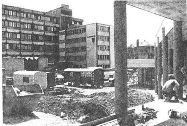
Nach dem Beschluß der Stadtväter soll der Platz rund um die neue Stadthalle „Rathausplatz“ heißen. Auch hier laufen die Arbeiten auf Hochtouren. Das Pflaster wird aus grauen Basaltsteinen bestehen und ohne Gehsteige überall auf gleichem Niveau verlegt. Pflanztröge mit Platanen sollen später den Beton ringsherum etwas auflockern. Foto: Sen-Gupta
