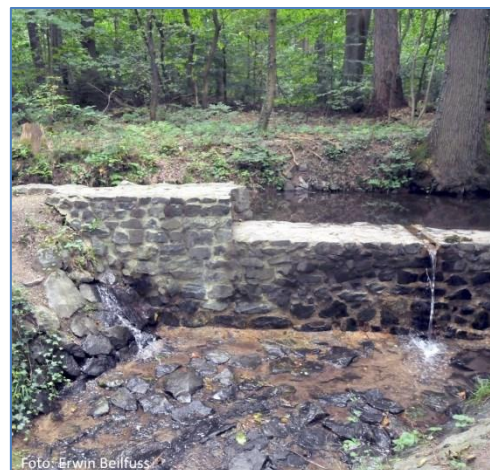
Werkgraben und Überlauf
