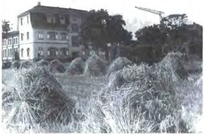
Auf dem Acker gegenüber der Firma Kammerer (die inzwischen auch einem Neubau weichen mußte) an der Hohemarkstraße wurde noch 1960 das Getreide geerntet. 1961 legte man hier den Grundstein für das neue Postamt, das zwar für die Oberurseler ziemlich abseits der gewohnten Wege lag, von dem aber behauptet wurde, auf einem Stadtplan läge es genau in der Mitte.
