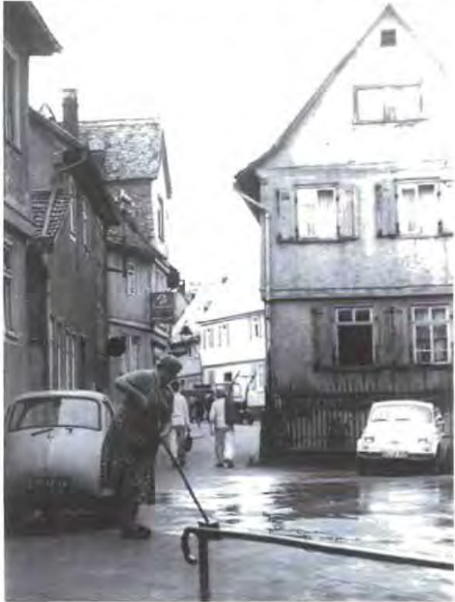
Nach dem Krieg und besonders nach der Währungsreform begann überall in der Stadt das Großreinemachen. Nicht nur vor, auch in den Häusern der Altstadt gab es jetzt Wasserspülung, und unter hüßlichem Verputz kam schönes Fachwerk zutage. Blick in die Weidengasse Anfang der 50er Jahre.
