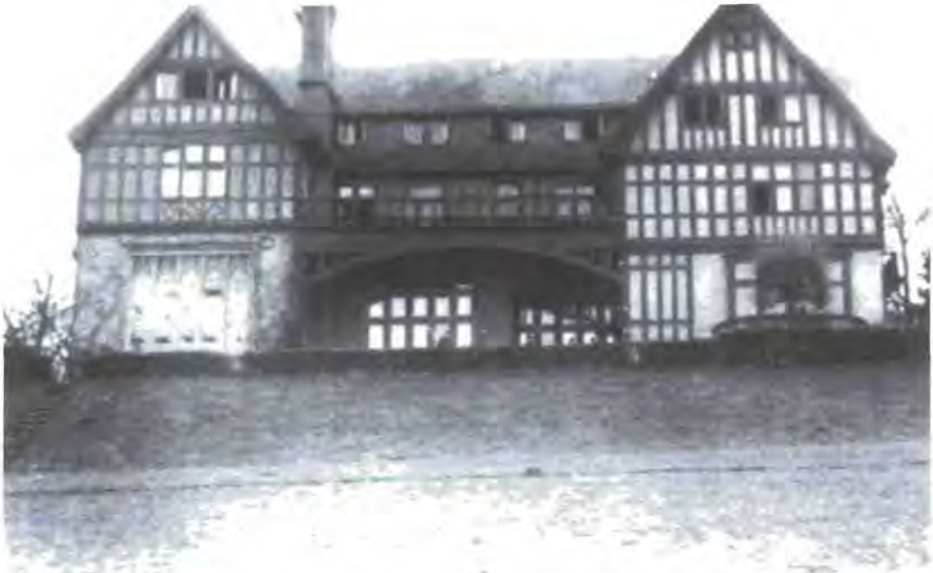
Die vormalige Villa Gans (aufgenommen 1946 von Felix Weil), 1909 erbaut von Ludwig Wilhelm Gans aus der Familie der Gründer der Cassella-Farbwerke, der von 1911 bis 1925 im Oberurseler Zimmermühlenweg die Firma Pharmagans zur Gewinnung von Sera aus Pferden betrieb. Das Haus mit großem Park wurde 1933 verkauft, ging 1934 an die Deutsche Arbeitsfront, war von 1935 bis -45 »Reichsschulungsburg«, diente dann den Amerikanern als »Country Club« und ist seit deren Auszug »Haus der Gewerkschaftsjugend«. Auf einer Freilichtbühne im Gelände findet seit einigen Jahren im Sommer das beliebte »Theater im Park« statt.
