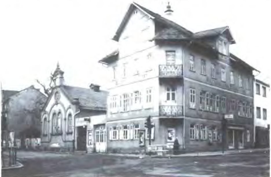
Das eindrucksvolle Gebäude an der wichtigsten Straßenkreuzung Oberursels hatte die Wirkung einer Pforte zur Innenstadt. Mit der abgeschrägten Ecke und den dekorativen Balkonen betonte es zusätzlich die Bedeutung des Platzes. Die hohe Platane links vom Saalgebäude stand im ehemaligen Wirtsgarten.
