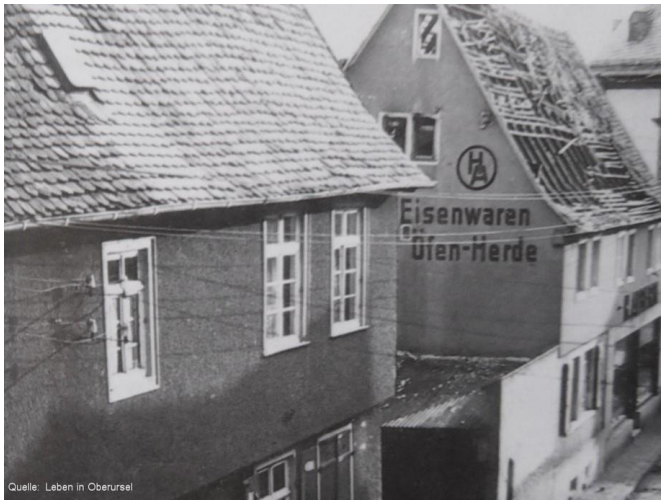
Beschädigung durch Brandbomben in der Nacht vom 24. auf den 25.08.1942
