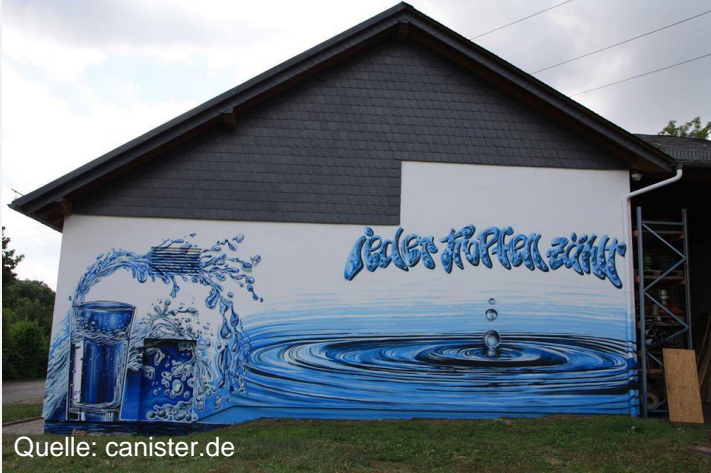
Wasserwerk Eschbach an der B 275
